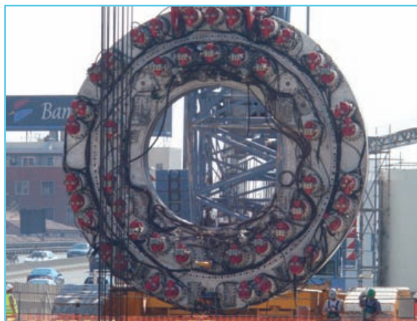
Foto 4. La corona exterior lleva 50 motores, 29 en la cara exterior y 21 en la cara interior.
