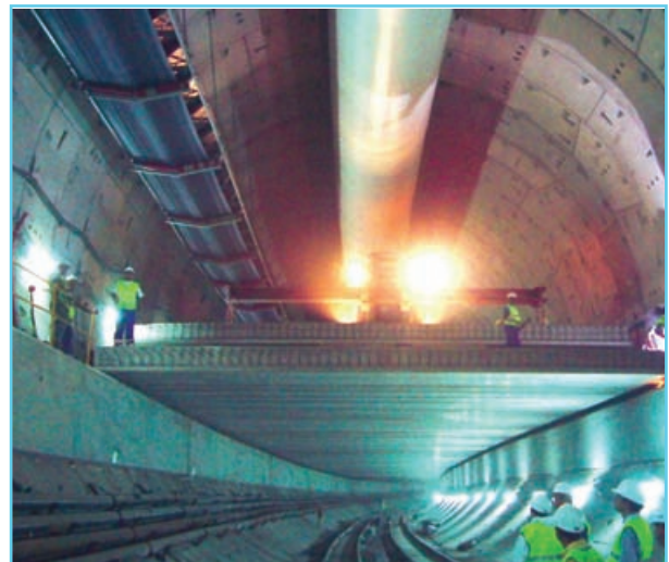
Foto 7. Instalación de la losa prefabricada.
