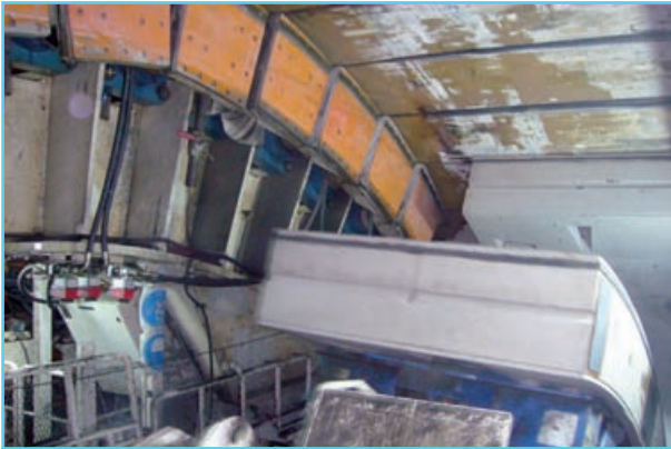
Foto 5. Erector de dovelas.
