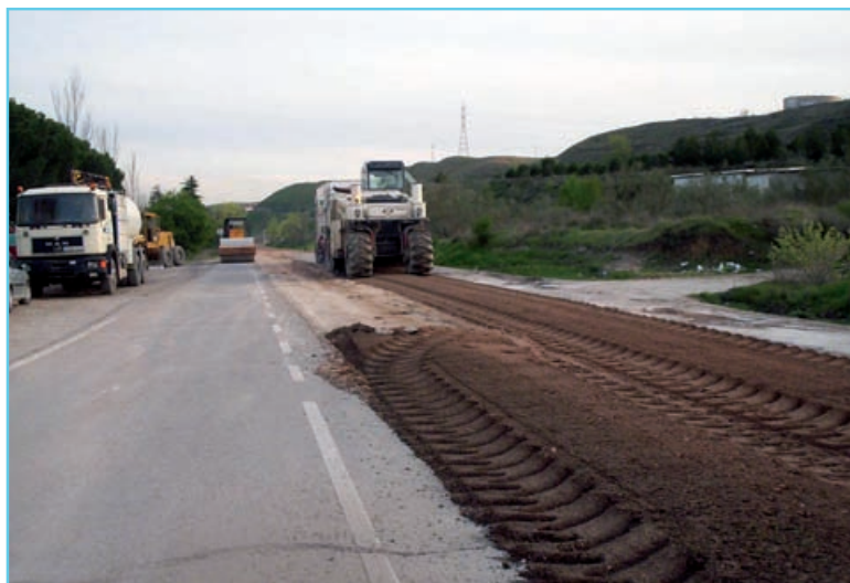
Foto 3: Preparación del terreno para su estabilización con cal en el desdoblamiento de una carretera
