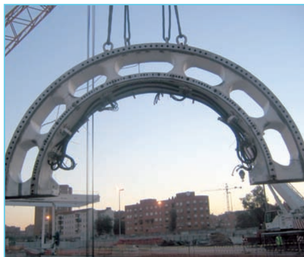
Foto 5. Anillo de sostenimiento, formado por dos piezas que arriestra los sectores del escudo.
