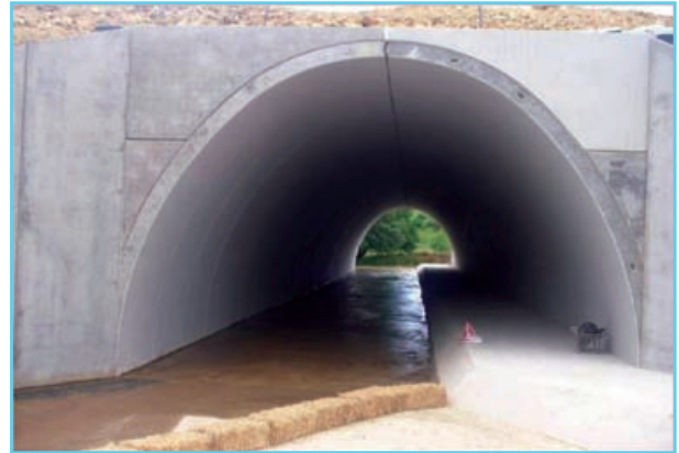
Foto 3. Obra de drenaje ampliada a bóveda y con acera para paso de reptiles y anfibios.
