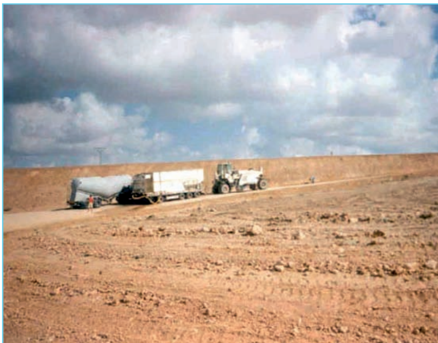
Foto 5: Tratamiento de estabilización con cal.
