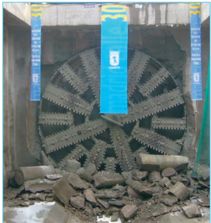
Foto 4. Cale del túnel Sur.
