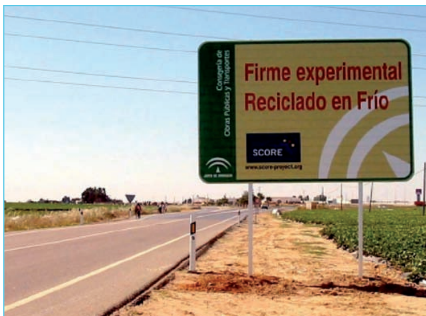
Foto 6. Vista del tramo experimental realizado gracias al apoyo de la Junta de Andalucía en la A-494.
