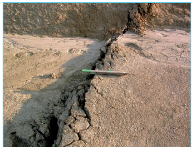
Foto 1: Estudio previo del terreno para estabilizar con cal, en Arcos de la Frontera
