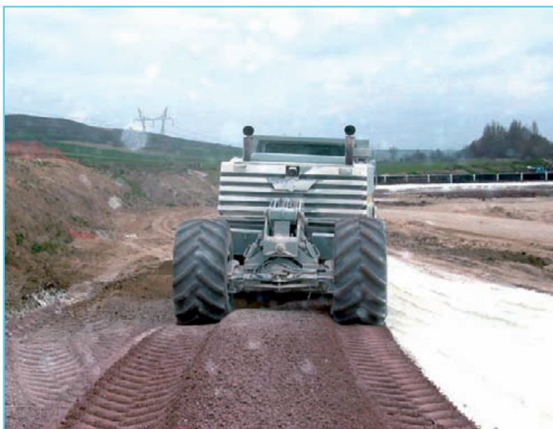
Foto 4: Al mezclarse la cal con suelos arcillosos se modifica la humedad del suelo y sus propiedades geotécnicas, mejora su trabajabilidad y su comportamiento frente al agua.
