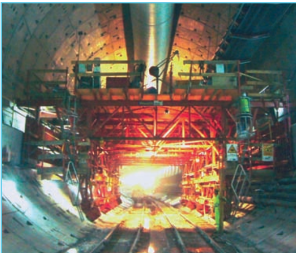
Foto 6. Encofrado para la ejecución de las ménsulas.
