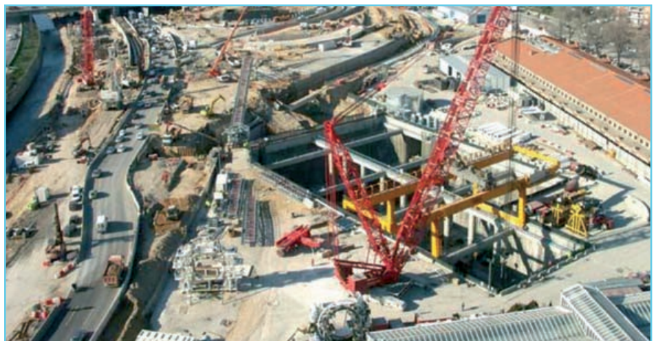
Foto 3. Pozo de ataque del túnel Sur.
