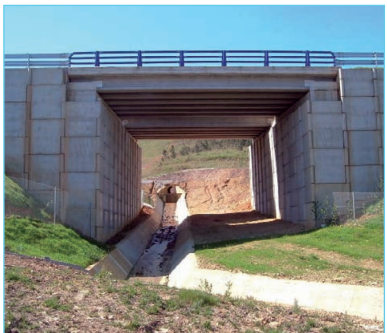
Foto 1. Paso de fauna específico para corzo.
